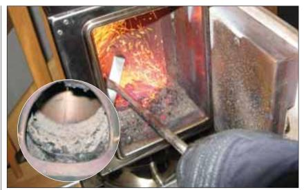
Wichtig ist, dass man nicht mit Wasser löschen darf. Die schlagartige Freisetzung von Wasserdampf würde zu großen Schäden führen.
